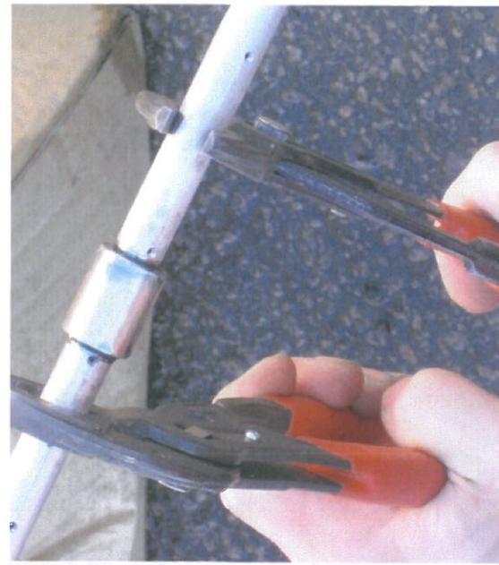
Bild 84. Montering av munstycksröret
